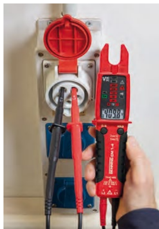
Spannungsmessung und Drehfeldprüfung
