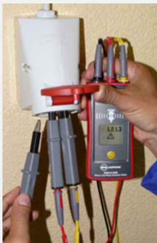
Überprüfung einer CEE-Drehstromsteckdose
