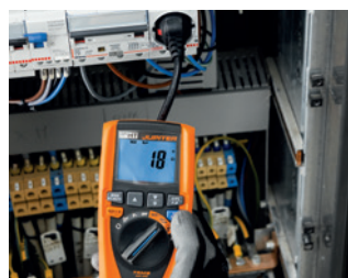
Impedanzmessung ohne RCD-Auslösung
