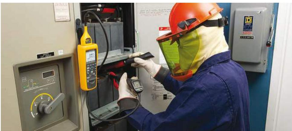
Einsatz des Fluke BT52X bei der Impedanzmessung zur vierteljährlichen Prüfung des Zellen-Innenwiderstands
