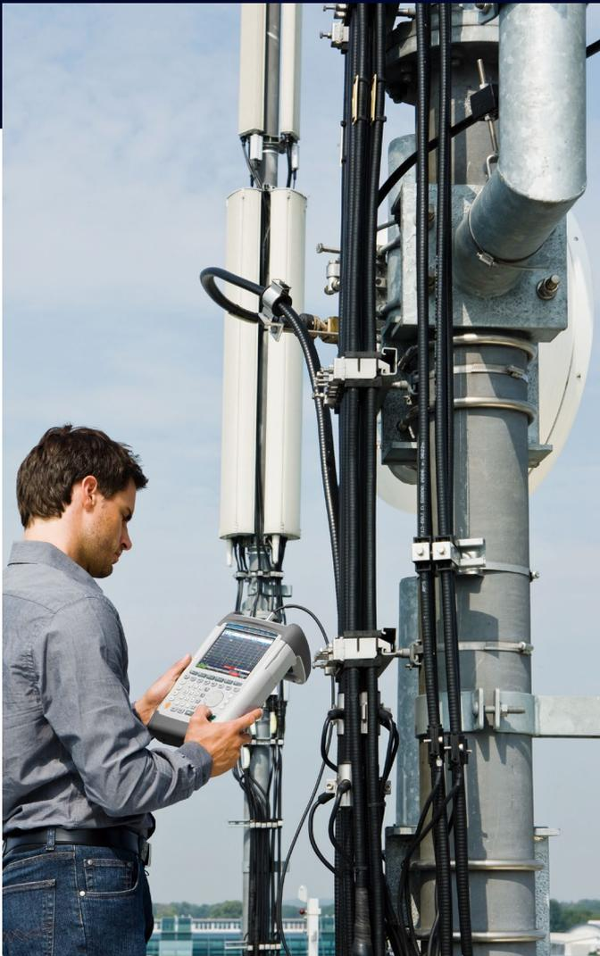
Kabelfehlstellenortung an einer Mobilfunkantennenanlage mit dem R&S®ZVH
